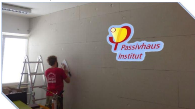
Bild: Wanddämmung innen fast fertig, Foto Wand: Passivhaus-Institut, Logo: Passivhaus-Institut, Arrangement REG.eV | C. Nintzel
